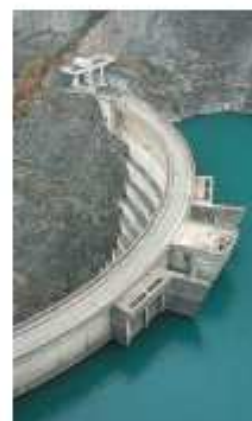
Barrage EDF de Monteynard
